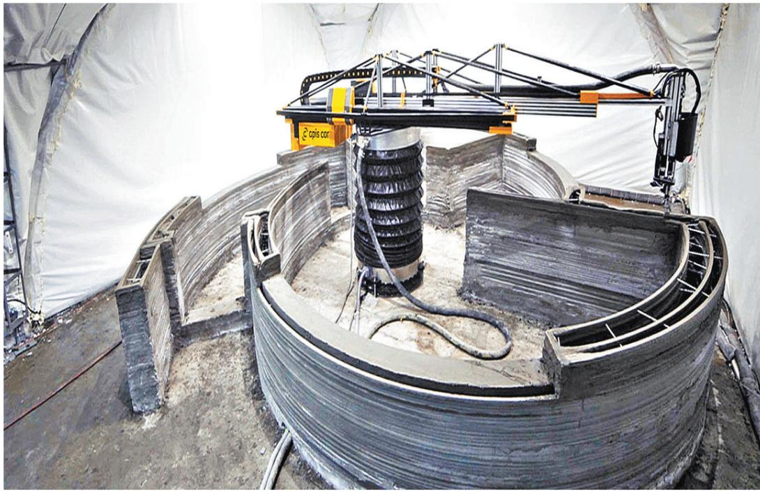
между ними. В эту полость потом укладывают утеплитель и арматура для дополнительной прочности. К слову, материал, заливаемый в принтер, также является ноу-хау — это смесь на цементной основе, схожая по характеристикам с высокопрочным бетоном. Она всем хороша, кроме одного — в сильные морозы требует периодической корректировки настроек печати. Но изобретатели не унывают и обещают уже к следующей зиме научиться использовать гео-
