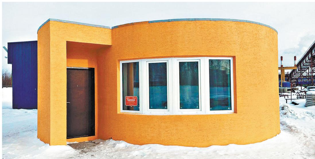
Ступинский дом-апельсин: принтерные стены не требуют дополнительной обработки, их можно просто покрыть яркой краской, радующей глаз.
