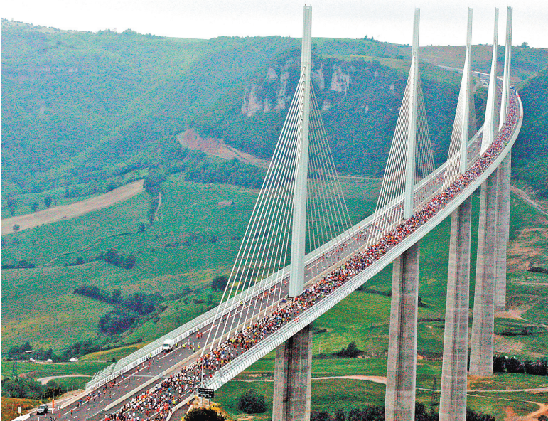
Виадук Мийо еще один проект Фостера. Один из самых длинных и высоких мостов во Франции — одна из его опор выше Эйфелевой башни.
