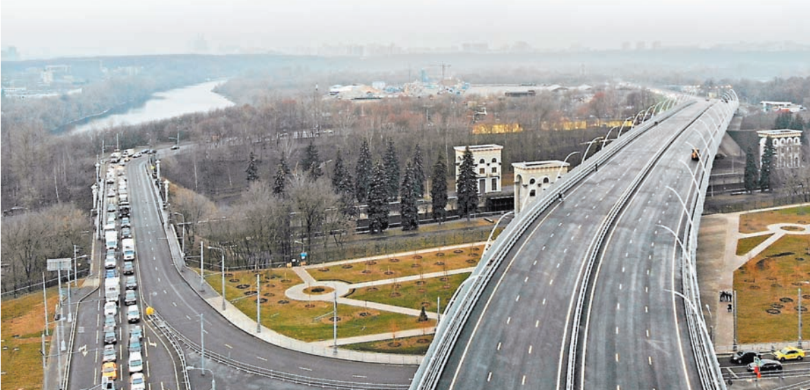
На мосту установлены шумозащитные экраны и дугообразные светильники.
